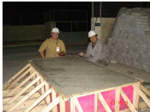
Figura 9 – (a) Coesão e trabalhabilidade do concreto; (b) bloco concretado com superfície acabada
