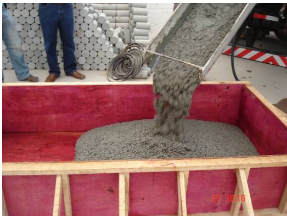
Figura 9 – (a) Coesão e trabalhabilidade do concreto; (b) bloco concretado com superfície acabada
