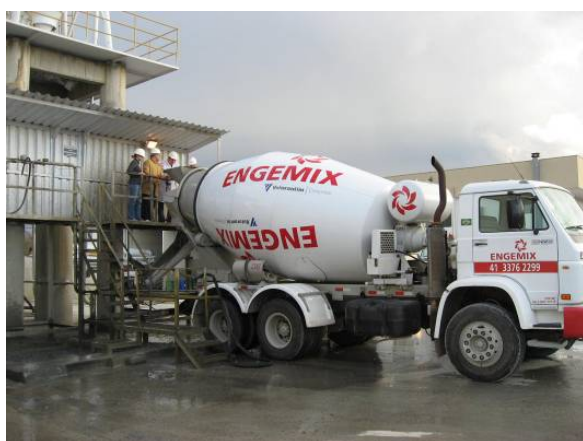
Figura 7 – (a) Dosagem em caminhão betoneira; (b) homogeneidade da mistura após aditivo
