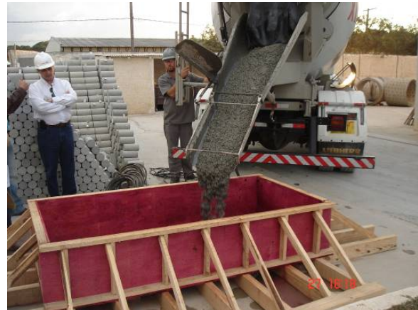
Figura 8 – (a) Abatimento – slump 200mm; (b) concretagem de bloco de aproximadamente 1,0m 3
