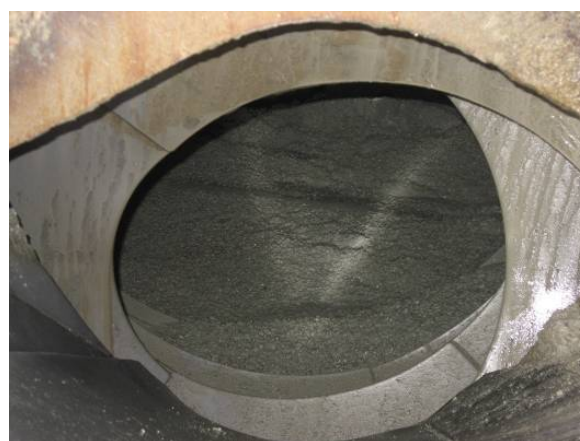
Figura 7 – (a) Dosagem em caminhão betoneira; (b) homogeneidade da mistura após aditivo
